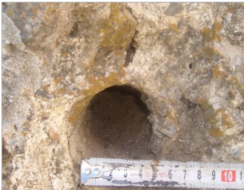
Fig.11. Pamje e vrimës së skelerisë së ndërtimit
